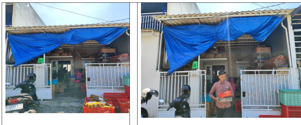
Gambar 4.2 Tampak dari depan CV. HERSA INDUSTRI ELEKTRIK SURABAYA
